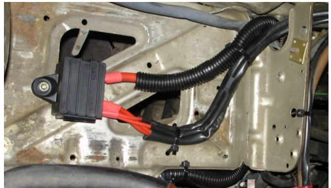
Pose d'un bloc de jonction dans l'ancien caisson de batterie pour les alimentations
